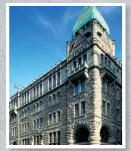
Легко поддающийся обработке горшечный камень получил широкую известность в начале 20 века, когда он широко использовался в качестве фасадного материала при строительстве зданий в югендстиле.
